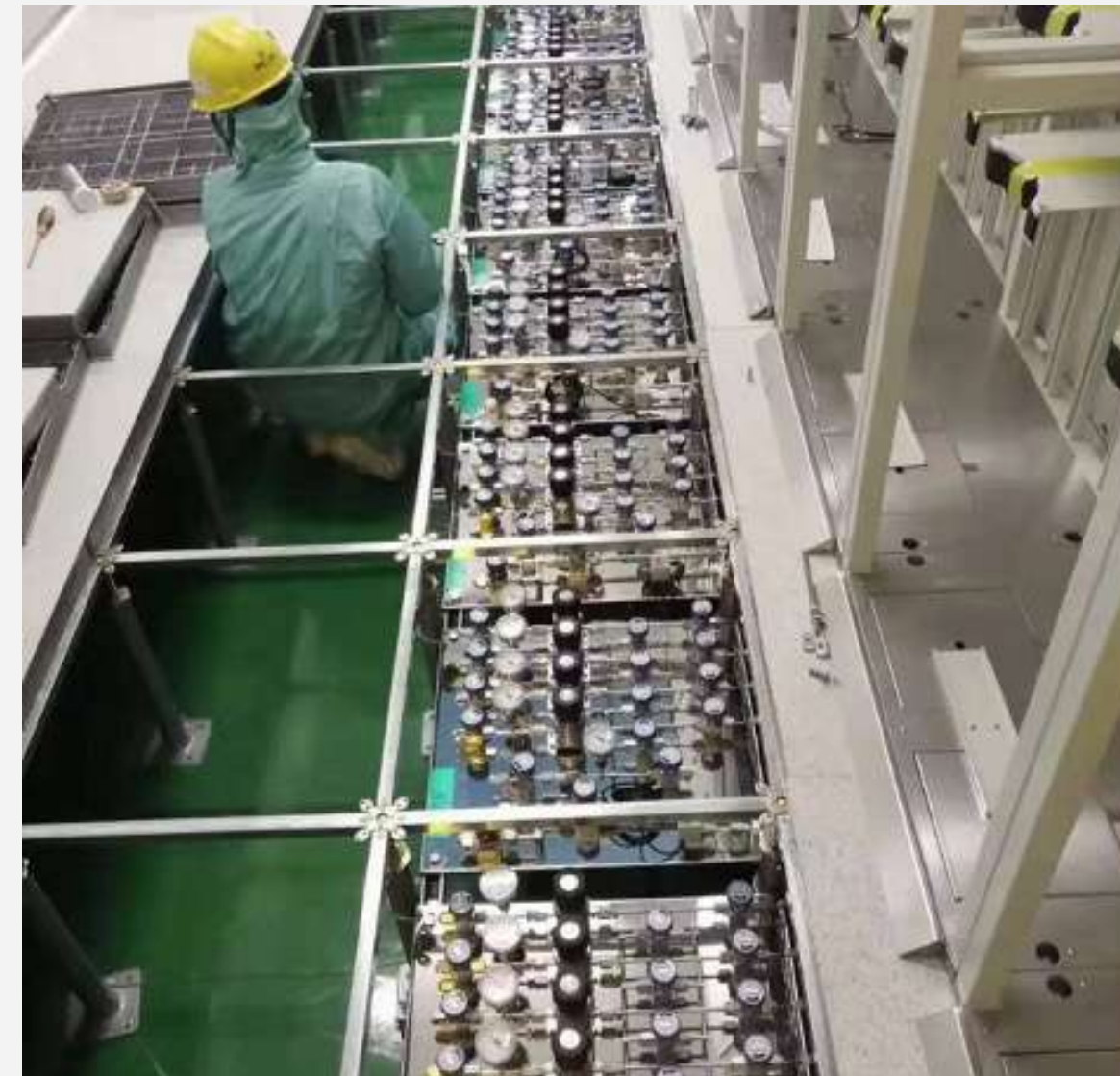
現場施工-二次配
